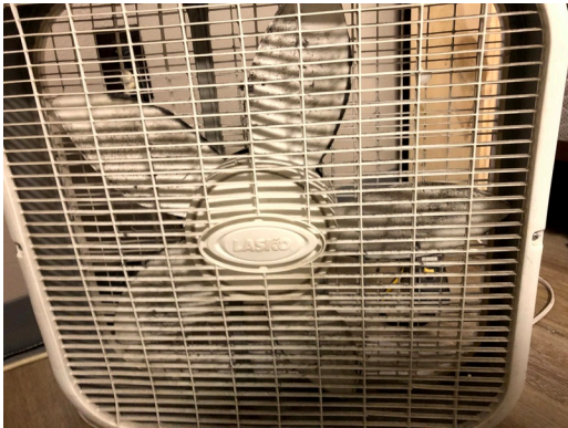
13. Dormatory - dirty fan
